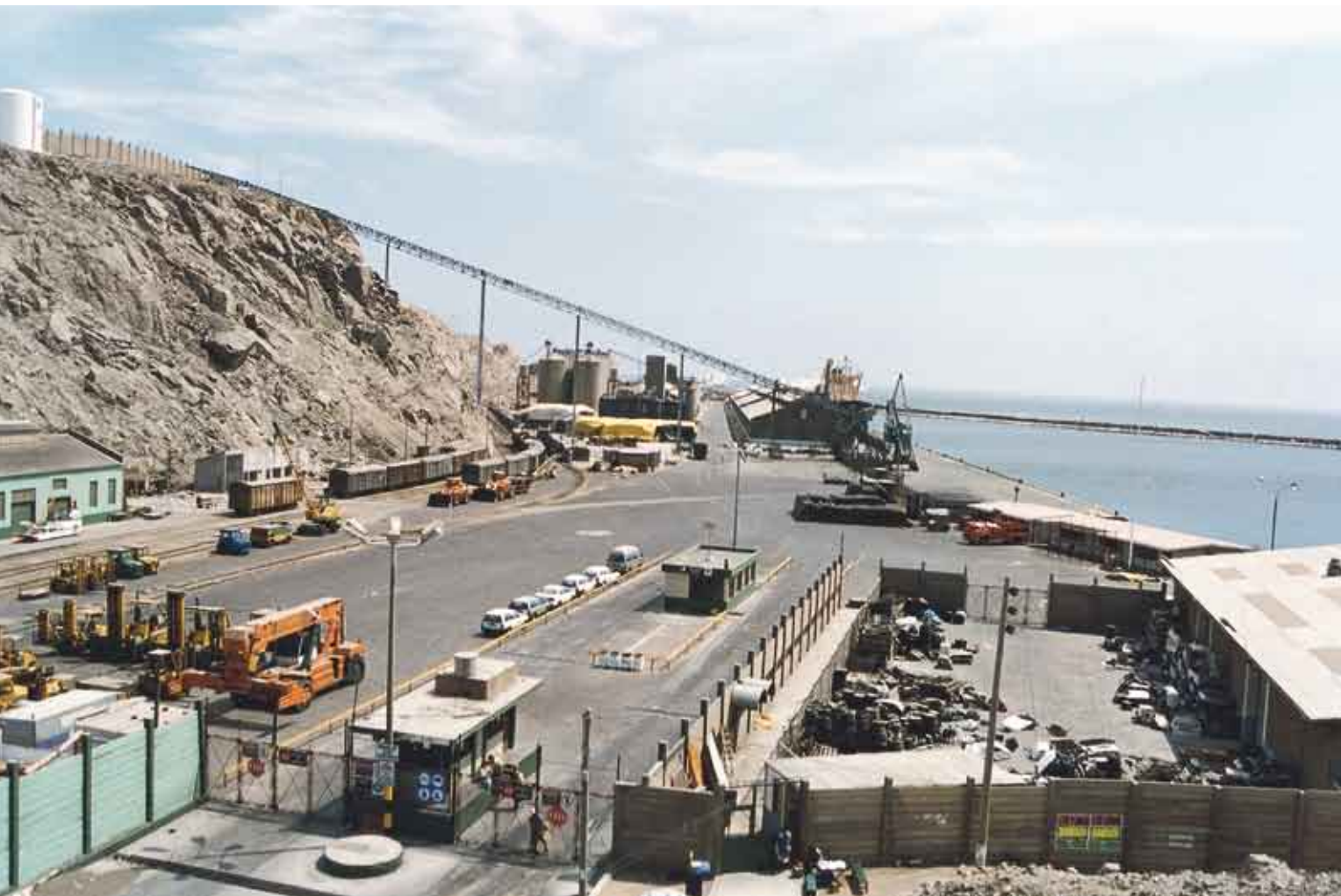
Puerto de Matarani en Arequipa fue uno de los primeros concesionados. The port of Matarani in Arequipa was one the first to be given in concession.
